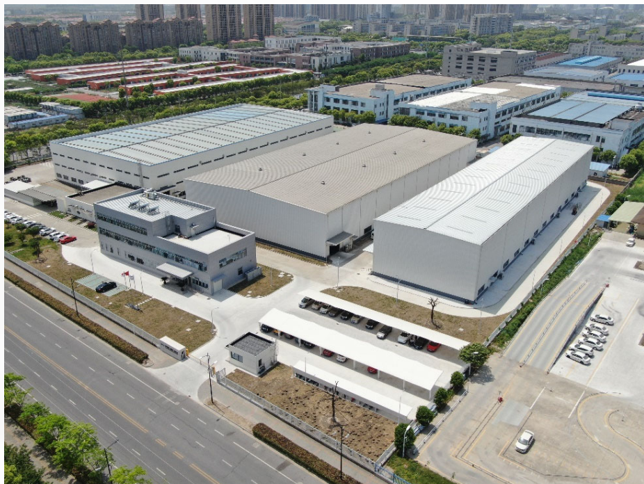
常熟現地法人外観 第3工場（右側）、研究棟（真ん中手前）
